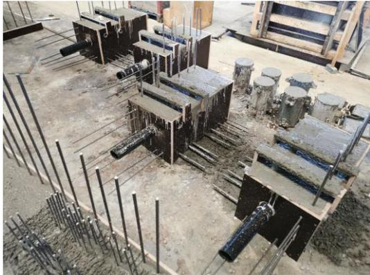
Abb. 19: Herstellung der Fertigteillisenen
