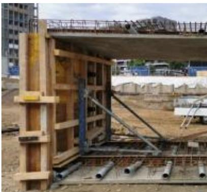
Abb. 31: lagenweise Herstellung von Ortbeton mit Holzschalung (entnommen aus [16])
