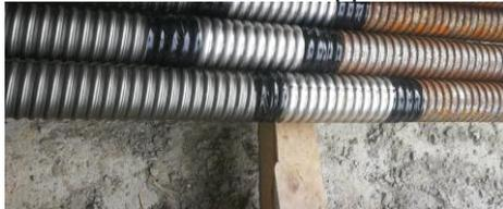
Abb. 14: Stoßen von Hüllrohren mit Muffen und Klebeband.
