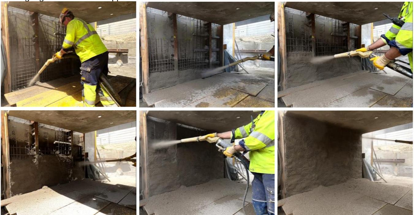
Abb. 30: Erganzung der Stegwand eines Bruckensegments mit Trocken-Spritzbeton. Oben dargestellt: unterschiedliche Bewehrungsgrade und Hullrohrtypen (entnommen aus [16])
