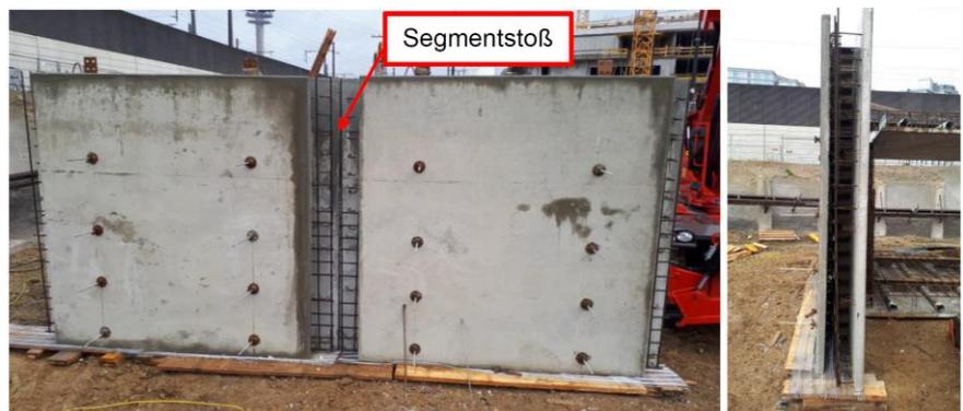
Abb. 32: lagenweise Herstellung von Ortbeton mit Schalelementen aus Beton (inklusive Offnung fur das Koppeln der Hullrohre) (entnommen aus [16])
